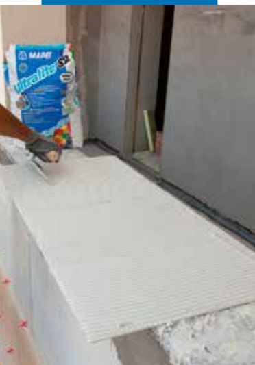
Rozprowadzanie kleju na spodniej stronie płytki
