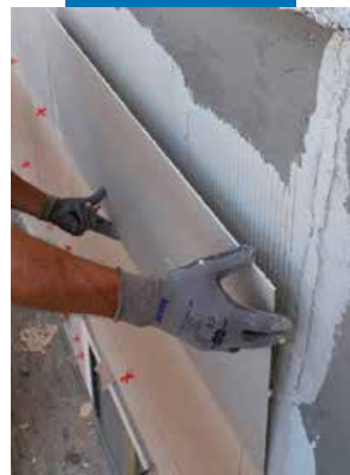
Montaż płyty z cienkiego gresu porcelanowego na elewacji
