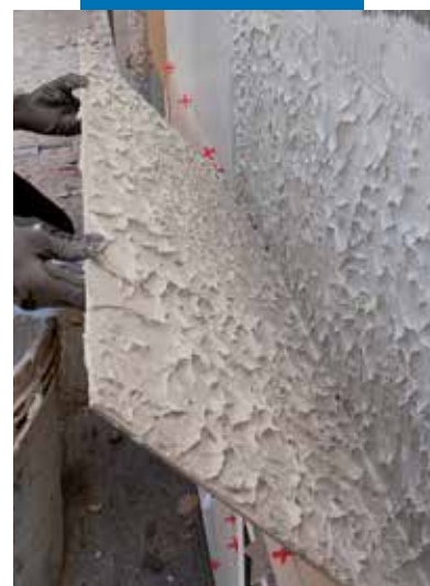
Prawidłowe wypełnienie spodniej strony płyty montowanej na elewacji
