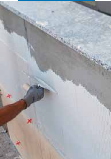
Rozprowadzanie kleju na podłożu, montaż na elewacji
