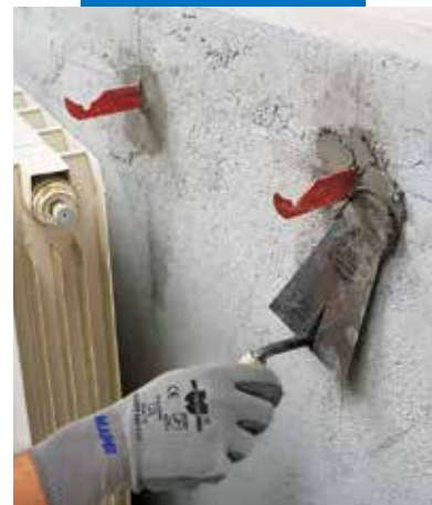
Mocowanie wieszaka kaloryfera z zastosowaniem Lampocem
