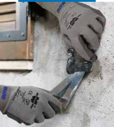
Zastosowanie Lampocem do mocowania śrub kotwiących okiennice
