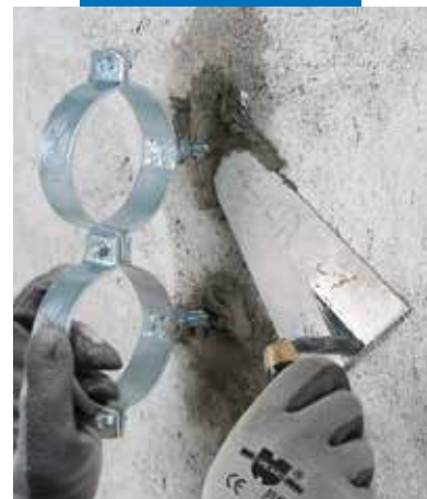
Montaż uchwyty do rur przy użyciu Lampocem
