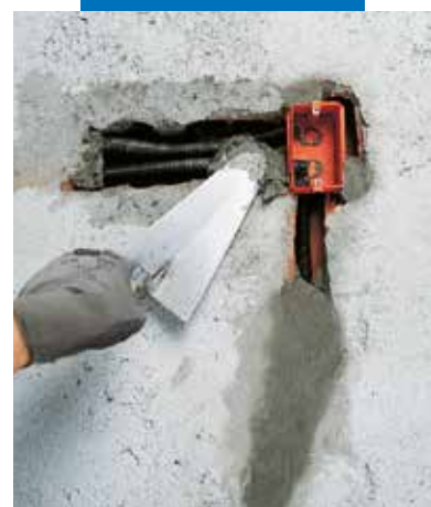
Mocowanie elementów instalacji elektrycznej z zastosowaniem Lampocem
