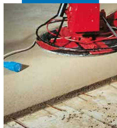
Mechaniczne zacieranie powierzchni podkładu z Topcem
