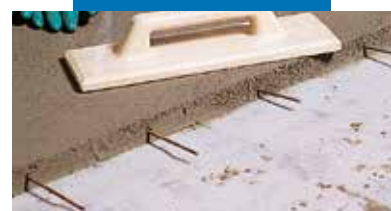
Podkład z Topcem z umieszczonymi w nim prętami zbrojącymi
