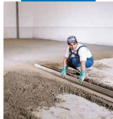
Przygotowywanie pasa poziomującego
