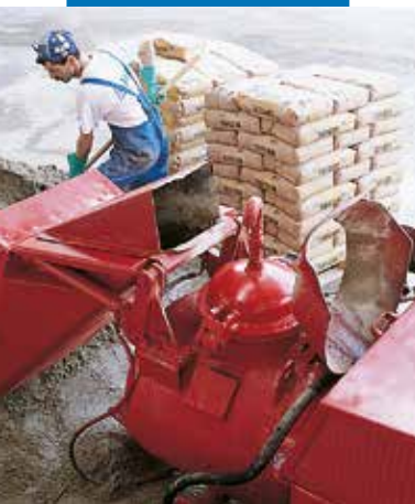
Mieszanie Topcem przy pomocy automatycznej pompy
