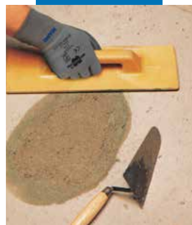
Naprawa podłoża: końcowe wygładzanie powierzchni
