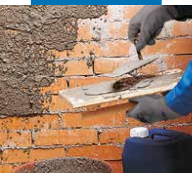
Narzucanie zaprawy z dodatkiem Planicrete
