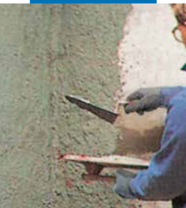
Narzucanie zaprawy z dodatkiem emulsji Planicrete
