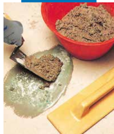
Naprawa podłoża: aplikacja zaprawy naprawczej
