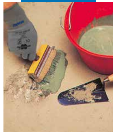
Naprawa podłoża: wykonywanie warstwy szczernej
