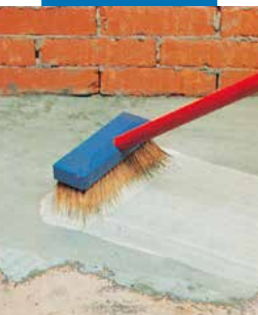
Gruntowanie emulsją z dodatkiem Planicrete
