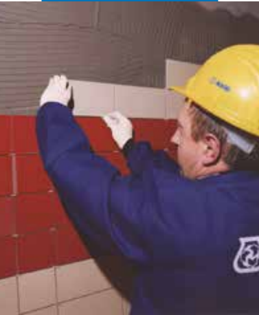
Układanie płytek ceramicznych na powierzchniach pionowych
