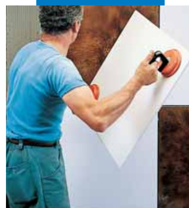
Montaż płyt KERAION na ścianie
