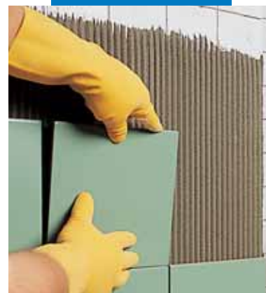
Układanie płytek na starej okładzinie ściennej
