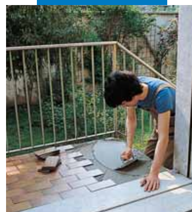
Wykonywanie warstwy uszczelniającej, wyrównywanie oraz klejenie z zastosowaniem Kerabond T + Isolastic
