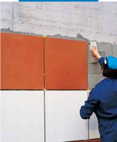
Mocowanie płytek wielkoformatowych przy pomocy Kerabond T + Isolastic
