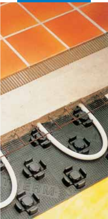
Montaż na ogrzewaniu podłogowym
