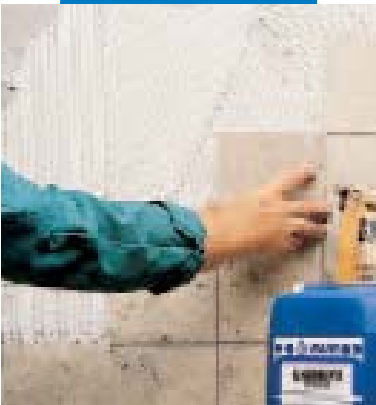
Montaż marmuru typu Jura przy użyciu białej zaprawy klejowej Granirapid
