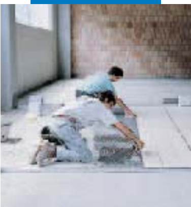
Montaż gresu porcelanowego w zakładach przemysłowych
