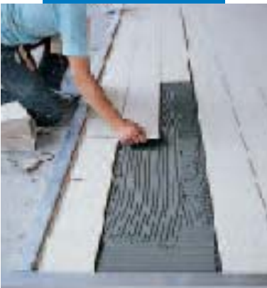
Montaż marmuru typu Jura przy użyciu białej zaprawy klejowej Granirapid
