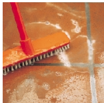
Czyszczenie za pomocą KERANET'u ciekłego i szczotki
