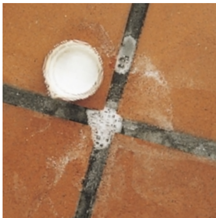
Usuwanie wykwitów
