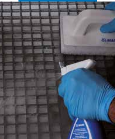
Rozpylanie Kerapoxy Cleaner na powierzchni wymagającej czyszczenia
