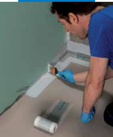
Przyklejanie taśmy Mapeband PE 120 na Mapegum WPS
