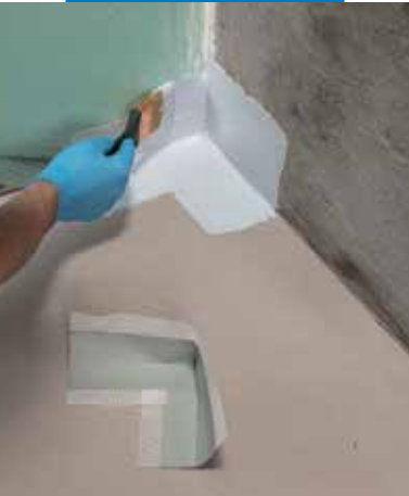
Przyklejanie narożnika Mapeband PE 120 na Mapegum WPS
