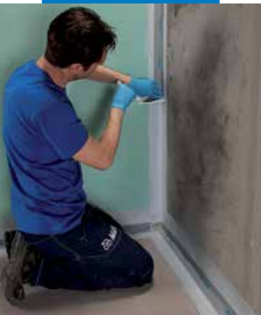
Przyklejanie taśmy Mapeband PE 120 na Mapegum WPS
