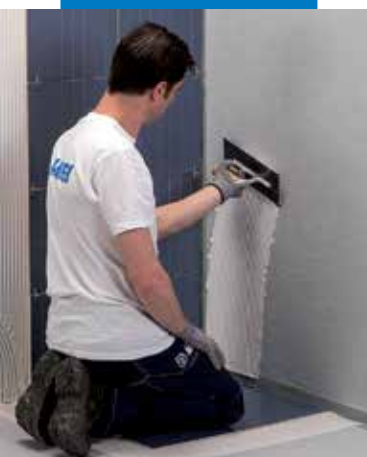
Montaż okładziny ściennej przy użyciu zaprawy klejącej Ultramastic III
