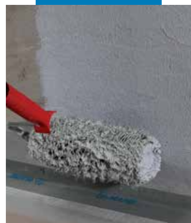
Nanoszenie warstwy Mapegum WPS wałkiem
