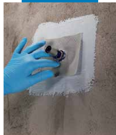
Montaż kawałka Mapeband PE 120 przy użyciu Mapegum WPS
