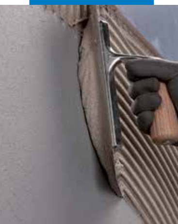
Montaż okładziny podłogowej przy użyciu zaprawy klejącej Keraflex Maxi S1
