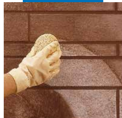
Czyszczenie i profilowanie fug gąbką
