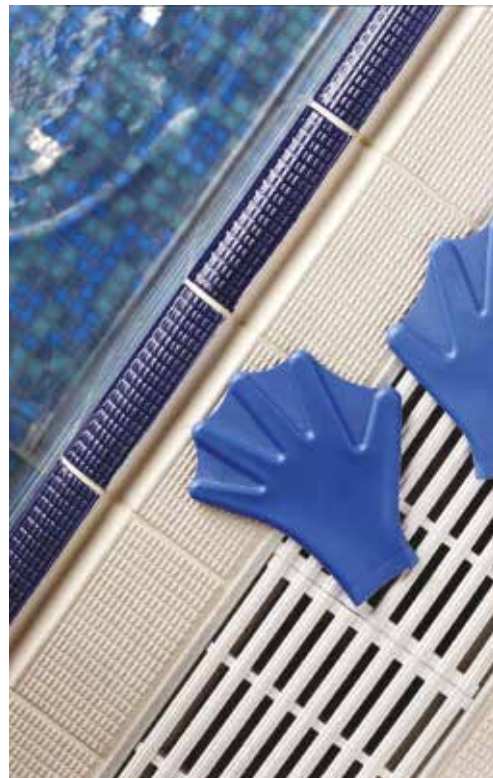
Przykład wykonania spoin w basenie wypełnionych Ultracolor Plus
