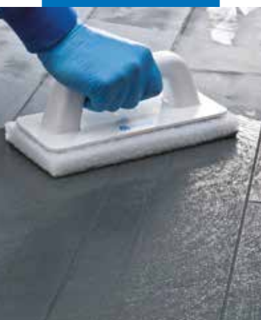
Czyszczenie i profilowanie fug pacą typu Scotch-Brite®
