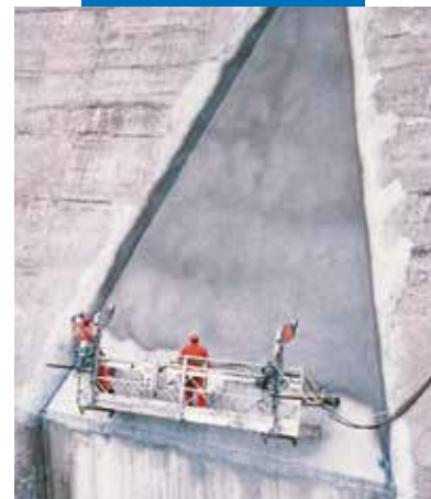
Nanoszenie Mapelastic metodą natryskową na zaporze wodnej
