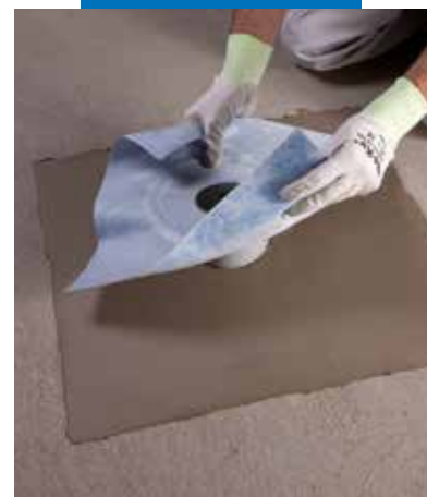
Montaż Drain Vertical na Mapelastic
