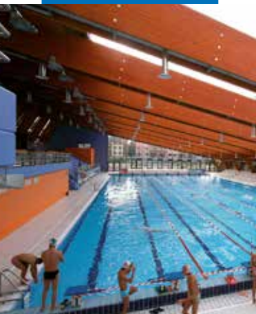
Basen wykonany z zastosowaniem izolacji Mapelastic; Scarioni, Mediolan, Włochy
