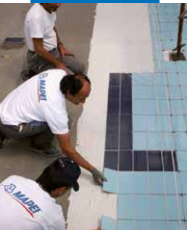
Montaż płytek ceramicznych na warstwie hydroizolacji Mapelastic
