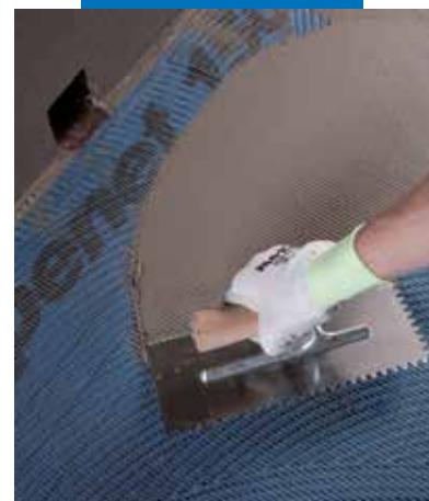
Rozprowadzanie hydroizolacji Mapelastic na siatce Mape-net 150
