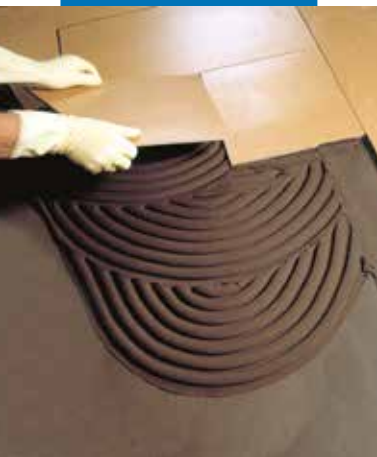
Montaż płytek gresowych na warstwie hydroizolacji Mapelastic
