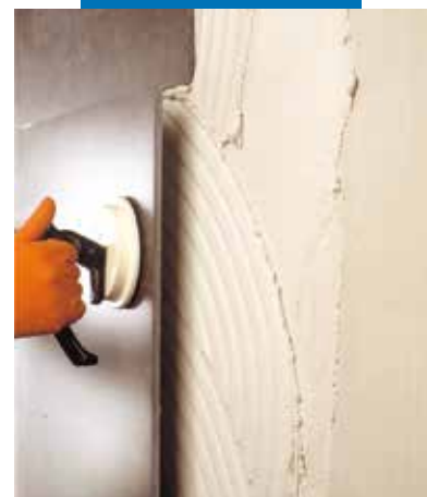
Montaż wielkoformatowych płytek gresowych z użyciem Elastorapid na fasadzie
