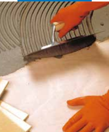
Montaż płytek gresowych z użyciem zaprawy klejącej Elastorapid na sklejce wodoodpornej
