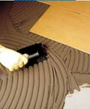
Rozprowadzenie zaprawy klejącej Elastorapid pacą zębatą na podkładzie cementowym
