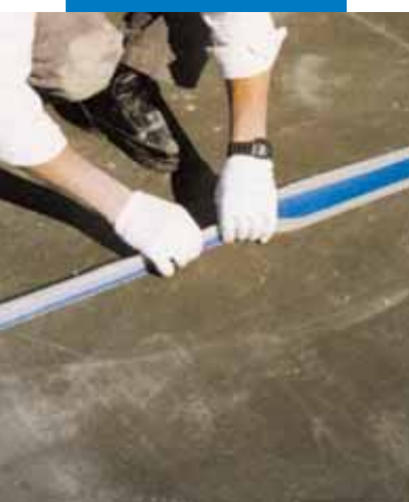
Przykład izolacji złącza dylatacyjnego na tarasie
