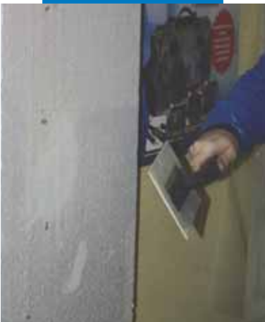
Dobijanie płyty styropianowej podczas instalacji
