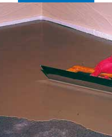
Rozprowadzanie masy Novoplan 21 przy użyciu metalowej szpachli na powierzchni zagruntowanej preparatem gruntującym Primer G
