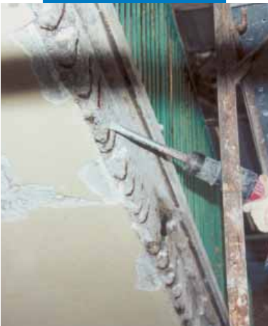
Naprawa gzymsów balkonowych: przygotowanie podłoża
