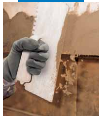
Naprawa gzymsów balkonowych: wygładzanie
