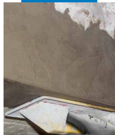
Naprawa krawędzi belek betonowych
