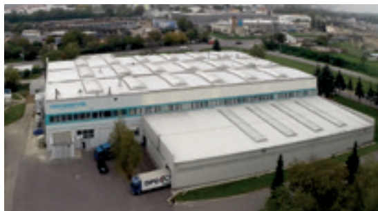
Zakład produkcyjny i centrum logistyczne w Znojmo (Czechy)
